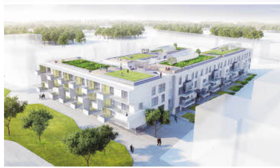
Ein Highlight sind die begrünten Dachterrassen mit drei Glashäusern. Bezugstermin: Herbst 2017
